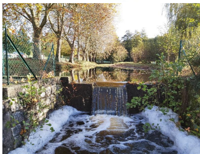
Plan d'eau avant travaux
